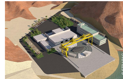
Das von ANDRITZ gelieferte Pumpspeicherkraftwerk Hatta wird über eine Gesamtspeicherkapazität von 1.500 MWh verfügen
